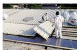
Operai specializzati nella rimozione dell'amianto
